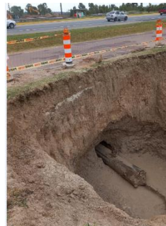
Figura 1: Proyecto y ejecución cruce Ruta Interbalsearia – Troncal Horneros. Vaina PEAD SDR 11 PE 100 DN 630 – tubería PEAD SDR 17 PE 100 DN 400. L=0.07km. Año 2024.
