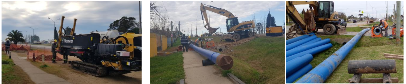
Figura 5: Instalación tubería PEAD DN 400 SDR 17 PE 100 con tuneleo teledirigido. Año 2023.
