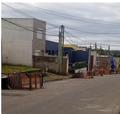
Figura 3: Sustitución FC DN 75 por PEAD DN 75 SDR 17 PE 100 DN 75, UGD. Año 2024.
