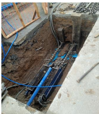
Figura 3: Sustitución FC DN 75 por PEAD DN 75 SDR 17 PE 100 DN 75, UGD. Año 2024.
