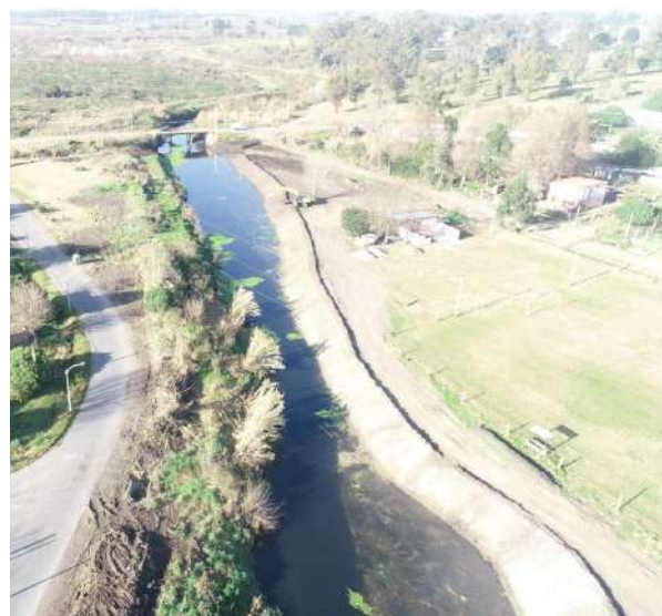
Intervención en el cauce
