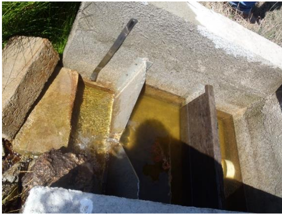
Fig. 5. Vertedero para aforo de caudal ambiental.
