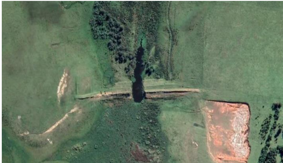
Fig. 4. Represa abandonada, se aprecia dique desmantelado.
