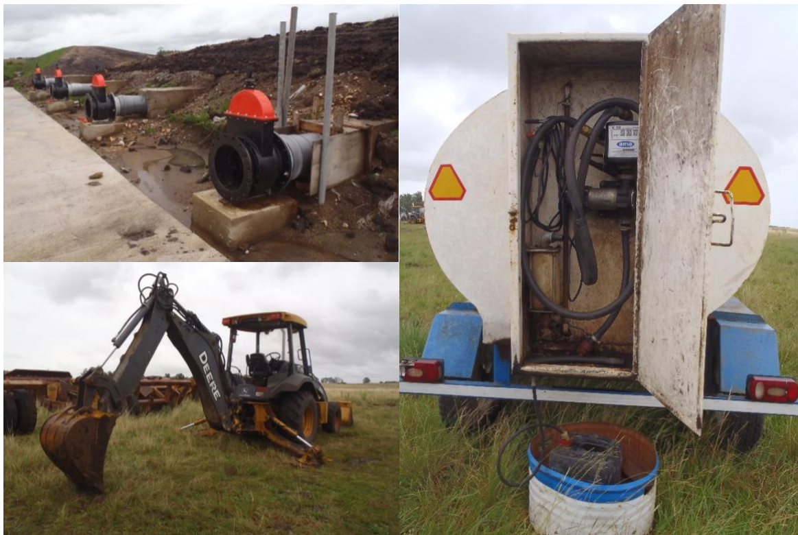
Fig. 1. Represa en construcción. Se aprecia, obra de toma y maquinaria, con detalle de camión surtidor de combustible.
