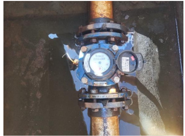
Fig. 6. Caudalímetro para control de caudal ambiental.
