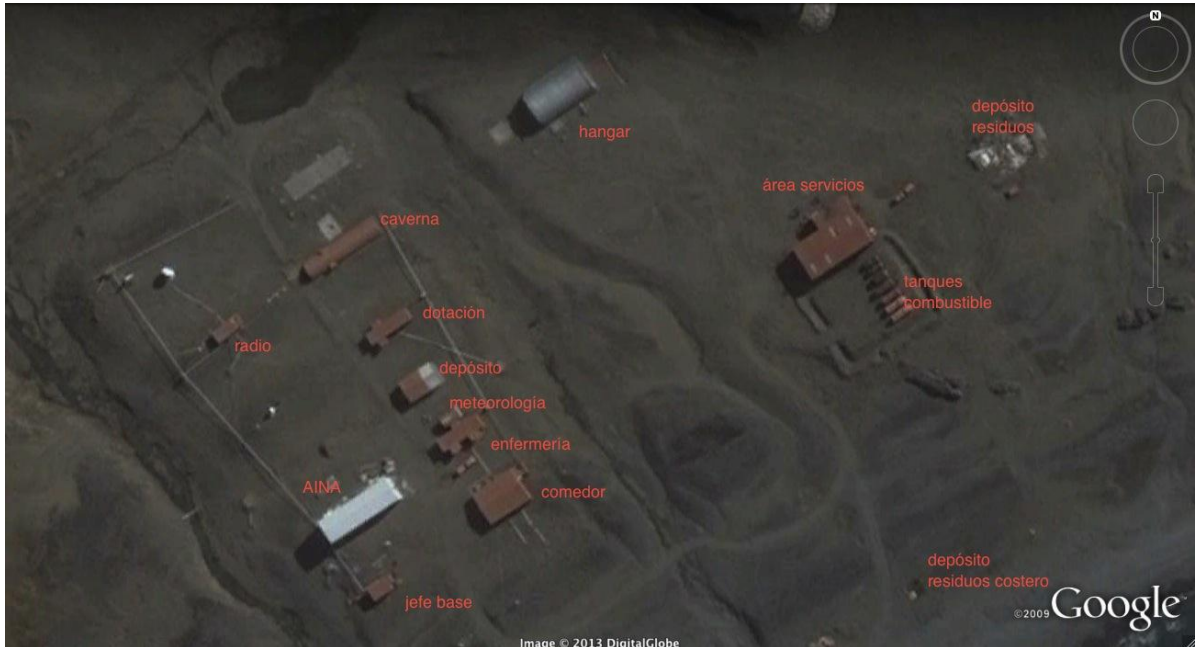
Fig.2. Fotos aéreas de las instalaciones de la base.
