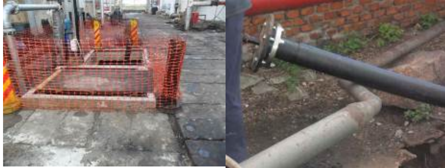
Figura 9 – Reacondicionamiento PB3 y línea de impulsión
