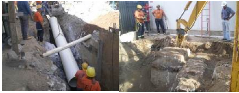
Figura 6 – Colocación colector NC y construcción de cámara de compuertas
