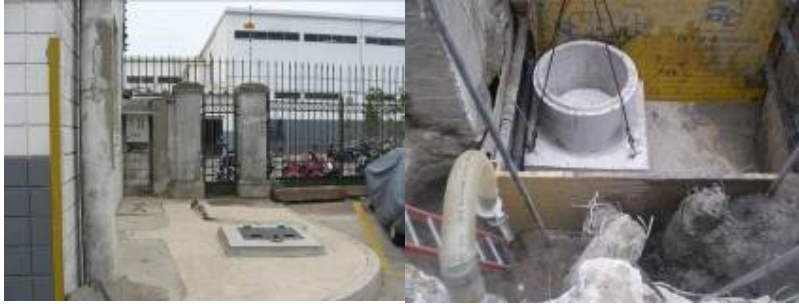
Figura 3 – PB1 y construcción PB2
