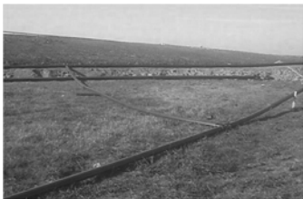
Foto 4: Líneas de conducción
