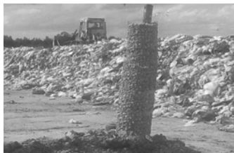
Foto 2: Pozo levantado al construir el relleno
