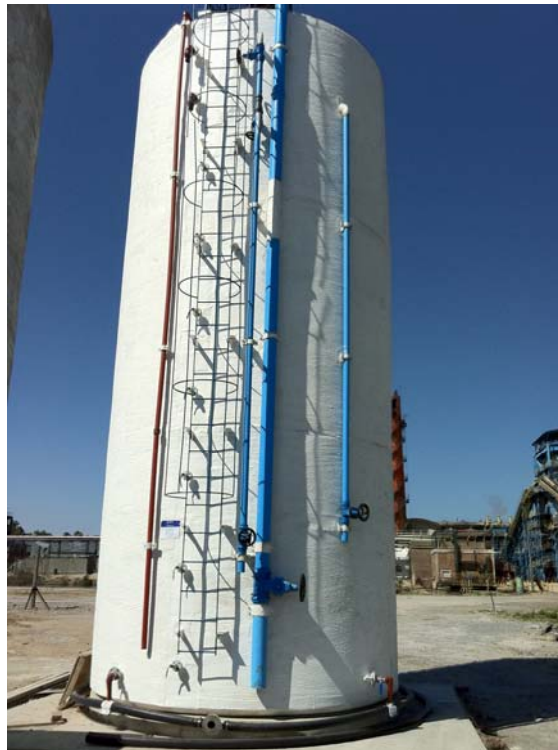
Figura 3 Reactor piloto de 100\text{ m}^3 .
