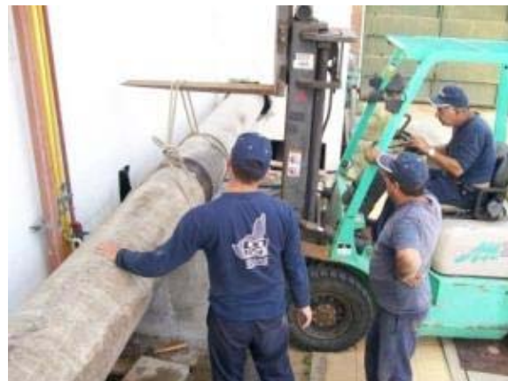
Figura 11 – Colocación Tubería FC 400.
