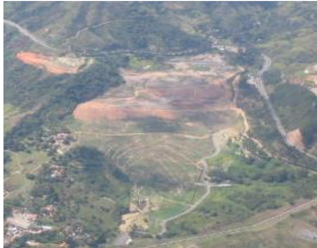
Foto 1 Panorámica en el año 2004 del relleno sanitario Curva de Rodas (Fuente Ingeniero Nelson Gaona).
