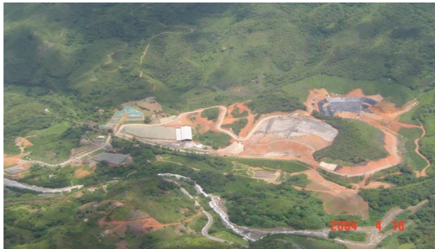
Foto 2 Panorámica relleno sanitario La Pradera (2004) Fuente EEVVM
