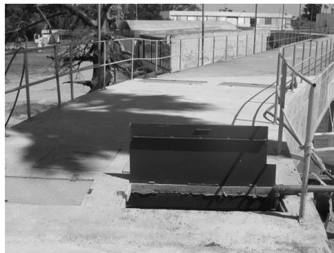
Imagen N° 2: intercloración en canal de agua decantada PV
